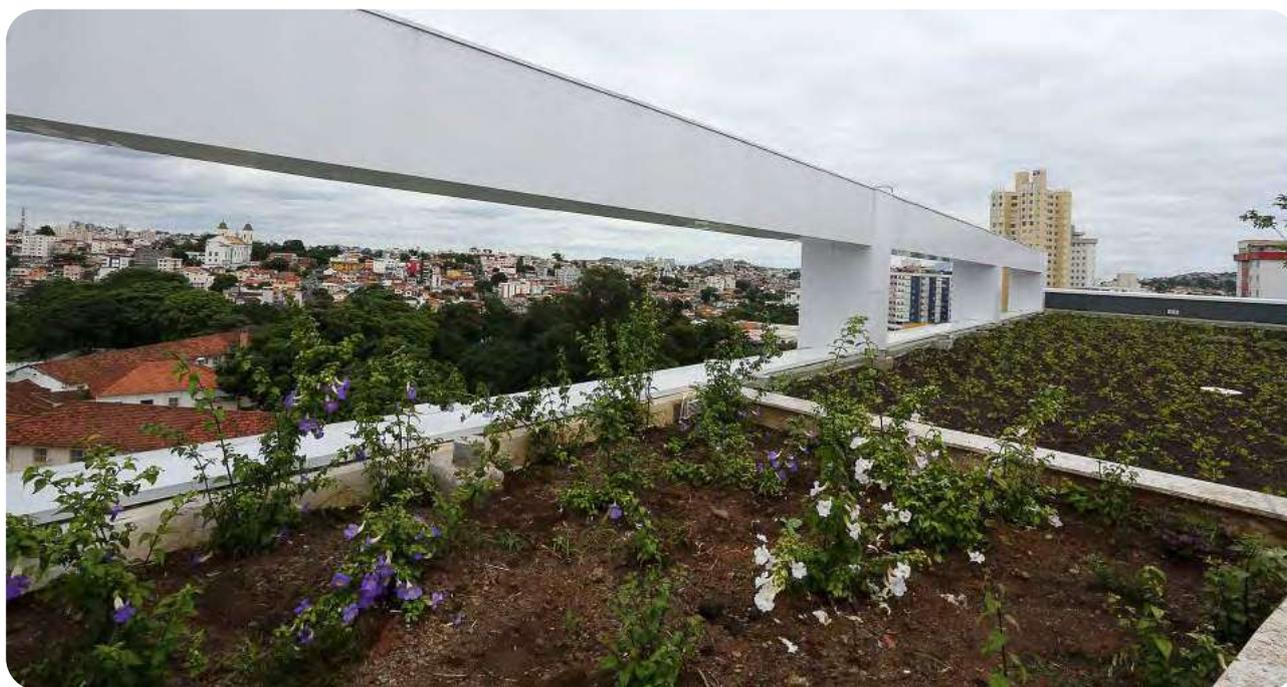
*Os jardins construídos sobre as lajes ajudam a melhorar a qualidade do ar e reduzem a possibilidade de alagamentos e o consumo de energia. Na foto, o telhado verde da Unidade Santa Efigênia.*
